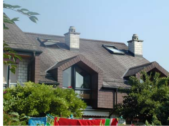
Ardesie per tetti in fibrocemento con amianto, foto: JMF/SLE, IST
